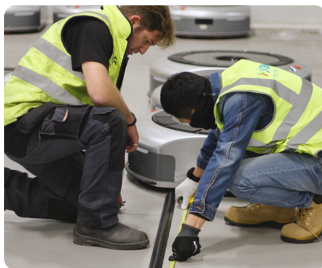
Étape 2. Mise en œuvre.
